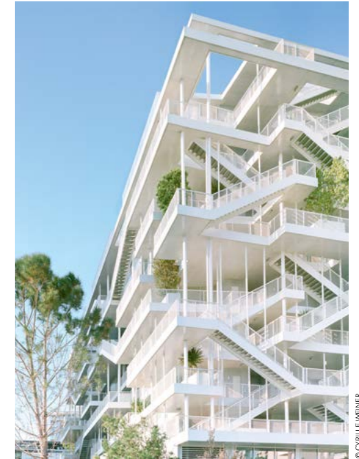
Anis, immeuble de bureaux bioclimatiques à Nice, livré en 2018
