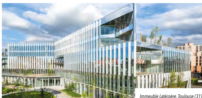
Immeuble Latécoère, Toulouse (31)
