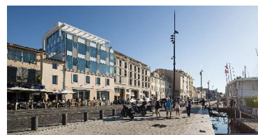
QUAI RIVE NEUVE Marseille, Bouches-du-Rhône
