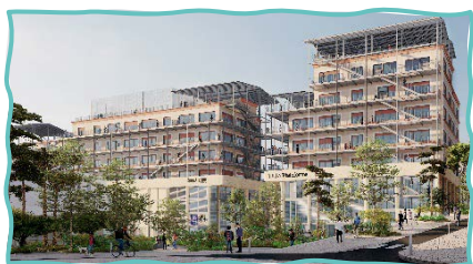
PLATEFORME MARSEILLE Bouches-du-Rhône
