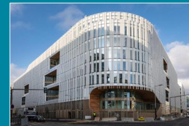
ORIGINE Nanterre Préfecture (Hauts-de-Seine)
