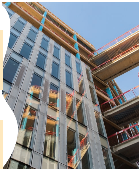
À Nanterre, 70 000 m 2 de bureaux en structure bois-béton
