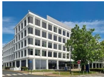
HELSINKI-IÉNA Parc Orly-Rungis 10 600 m 2
