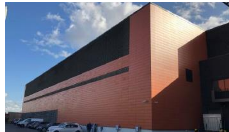
EQUINIX (Parc des Portes de Paris)
