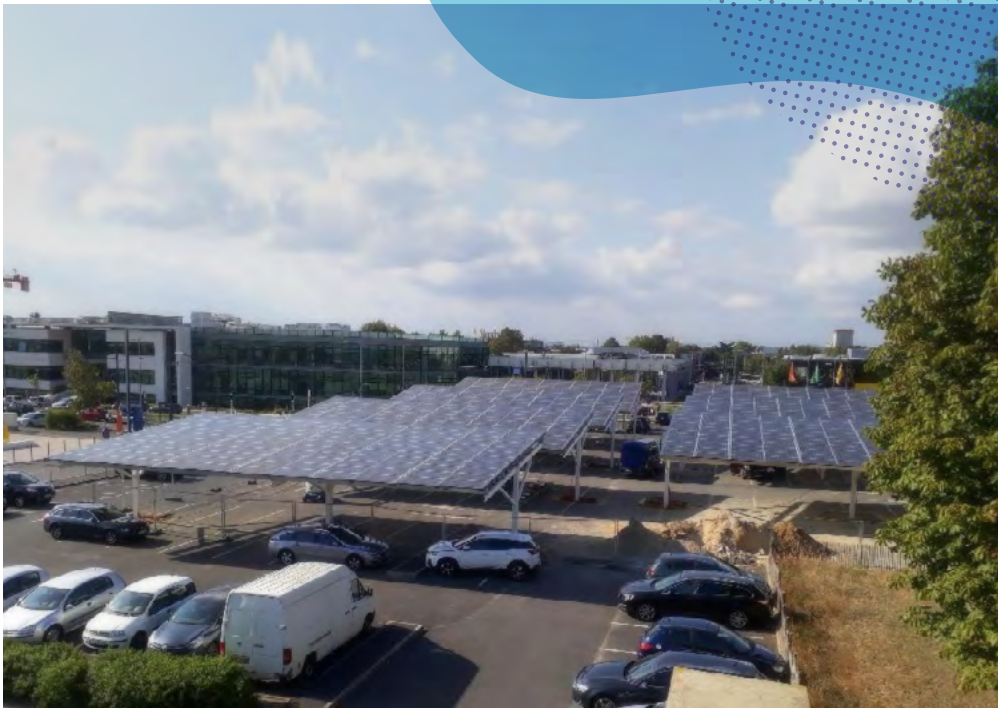
Ombrières photovoltaïques, Parc Paris-Orly-Rungis (94)
