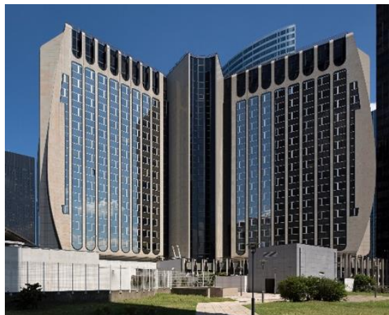
L'immeuble PB5 détenu par Icade à La Défense
