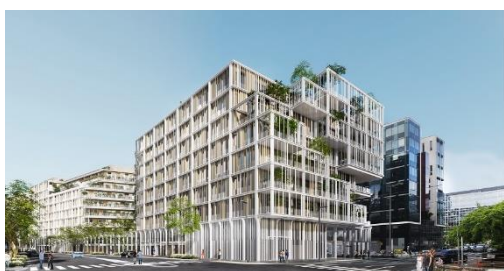
EDENN, Nanterre (92), développée en structure mixte bois/béton/métal
