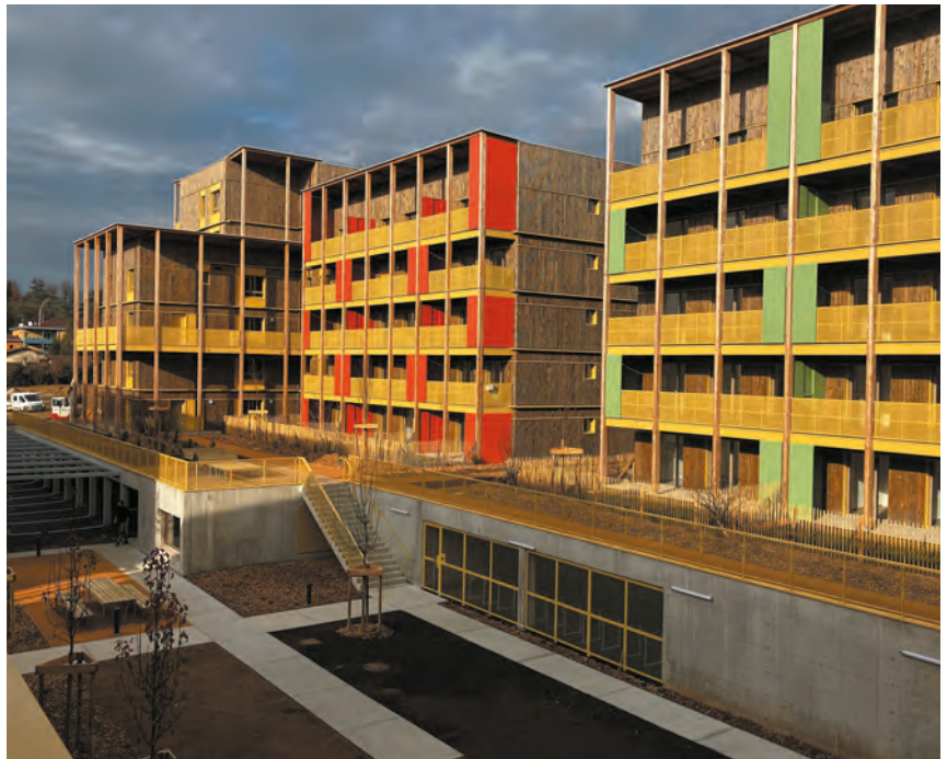
Origine, Trévoux (69). Un ensemble de 84 logements et une chambre d'hôtes pensé pour répondre à un climat plus chaud grâce notamment à l'utilisation du bois, qui participe au rafraîchissement des appartements en été et conserve la chaleur l'hiver.
