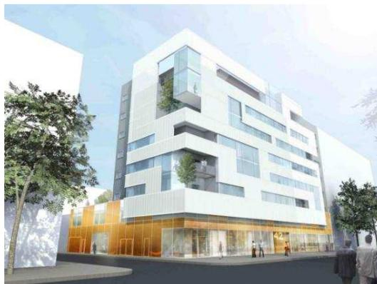
Issu de la restructuration de l'ancien siège de Candia réalisée par le promoteur DCB International, l'immeuble a bénéficié d'une éco-rénovation lourde exemplaire avec 80% des matériaux issus de la phase de déconstruction qui ont pu être recyclés ou valorisés. Il est labellisé PEQA-BBC (Performance énergétique et qualité associée, bâtiment basse consommation).
