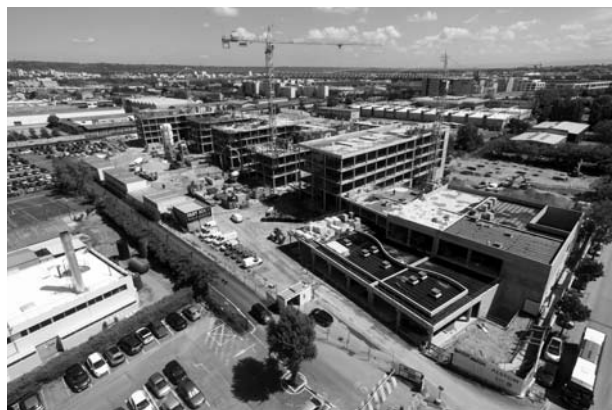
Projet Silky Way – Chantier à fin 2014
