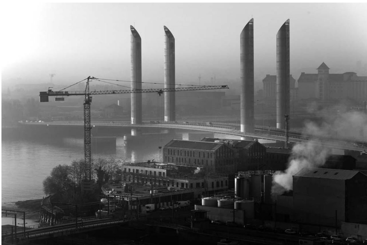
Quartier des Bassins à flot
