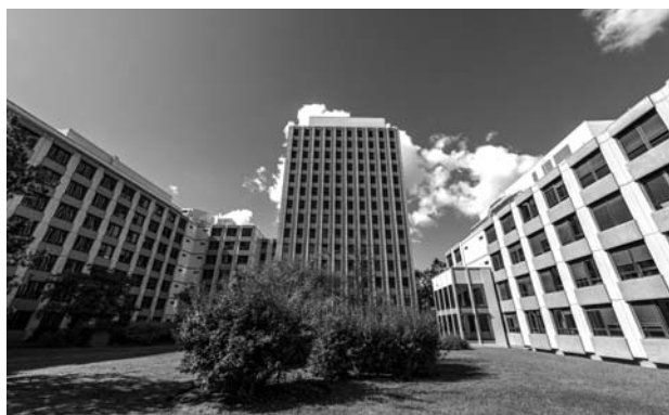
Projet Areva – Immeuble Lafayette
