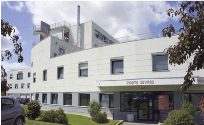
Restructuration Polyclinique L'Atlantique à Saint-Herblain. Investissement 8,2 M€
