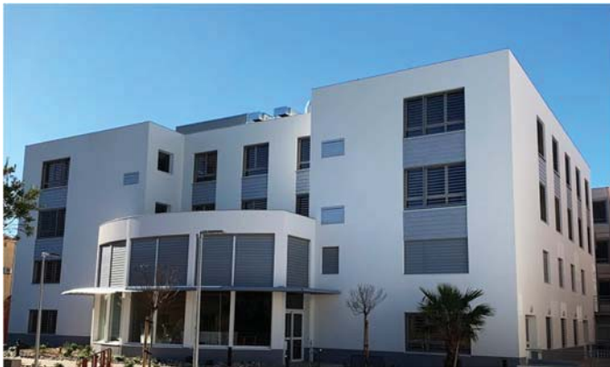
Extension-rénovation Centre SSR Le Floride, au Barcarès. Investissement 7,4 M€
