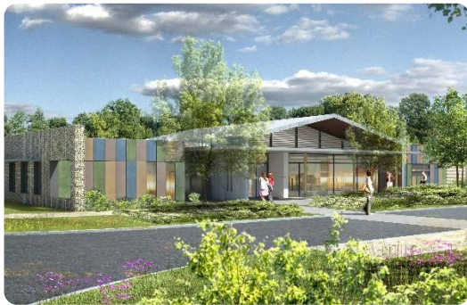
EHPAD (Saint Denis de Pile, 33)
