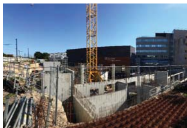
POLYCLINIQUE DU PARC (travaux d'extension) Caen, Calvados
