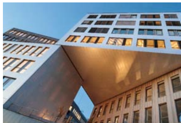
EKO ACTIVE, QUAI 8.2 ÎLOT BC Marseille, Bouches-du-Rhône
